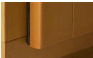
Los nuevos conceptos en la fabricación de ventanas de madera incluyen juntas de estanqueidad instaladas en el perímetro de los perfiles de marco y hoja, así como juntas centrales instaladas en marco que tienen como misión aumentar los niveles de hermeticidad de los cuadros ante la presión ejercida por el cierre perimetral de los herrajes.
